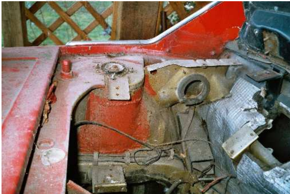
Stehwand im Motorraum links
